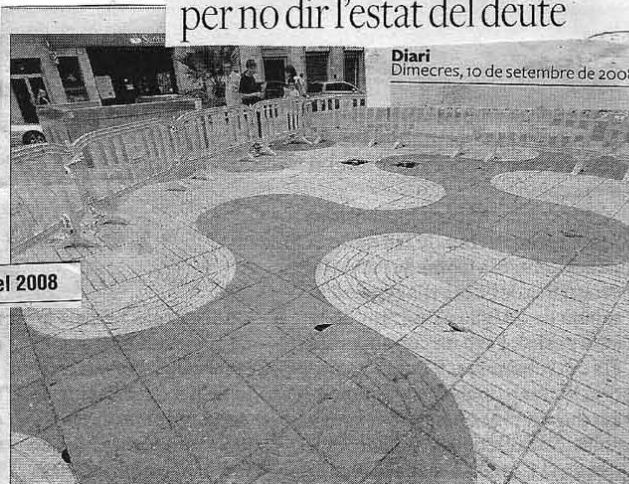
La 'mascletà' malmet el paviment de la plaça. Fins a una quinzena de rajoles de la plaça Alfons XII de Tortosa es van trencar arran de la mascletà celebrada diumenge al migdia. FOTO: JOAN REVILLAS
