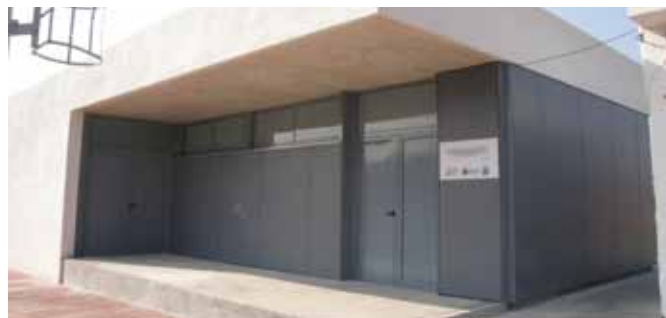
Construcció nous vestidors. Bitem
